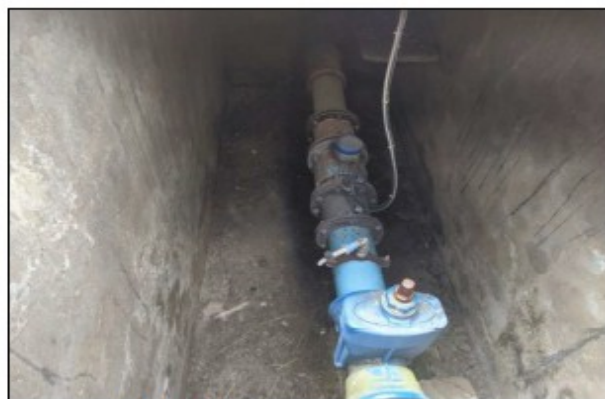
Figura 14 – Detalhe para a macromedição do reservatório.
