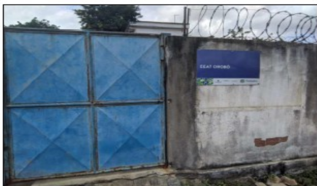
Figura 7 – Estação Elevatória de Água Tratada (EEAT) Orobó.
