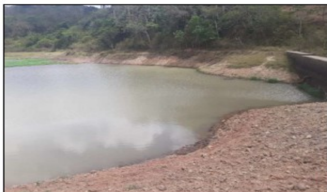
Figura 6 – Barragem do escuro após dragagem do fundo. Detalhe para o nível do sifão de captação, acima do nível d'água. Fonte: COMPESA.
