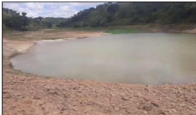
Figura 4 – Barragem do escuro após dragagem do fundo. Fonte: COMPESA.
