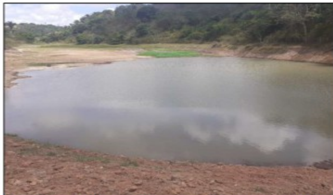
Figura 3 – Barragem do escuro após dragagem do fundo. Fonte: COMPESA.
